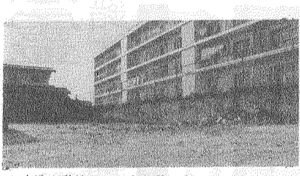
木造2階建てだった奥井荘も全て取り壊され、いまはがらんとした空き地に
