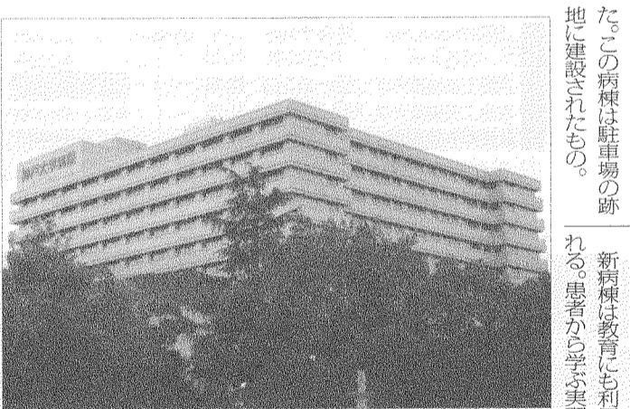
お目見えした新病棟。多方面での利用が期待される
