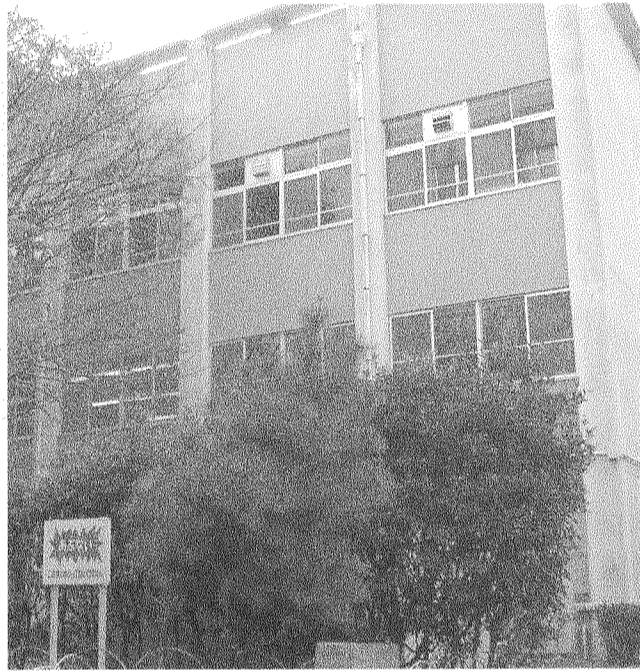
アスベストが発見された施設の一つ、文学部新館。(撮影=笹川和彦)
